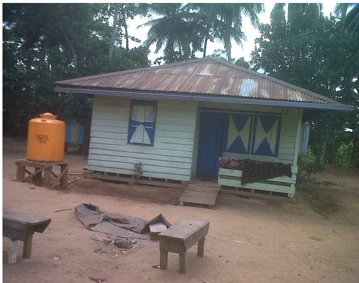
Rumah, profil tank, WC
